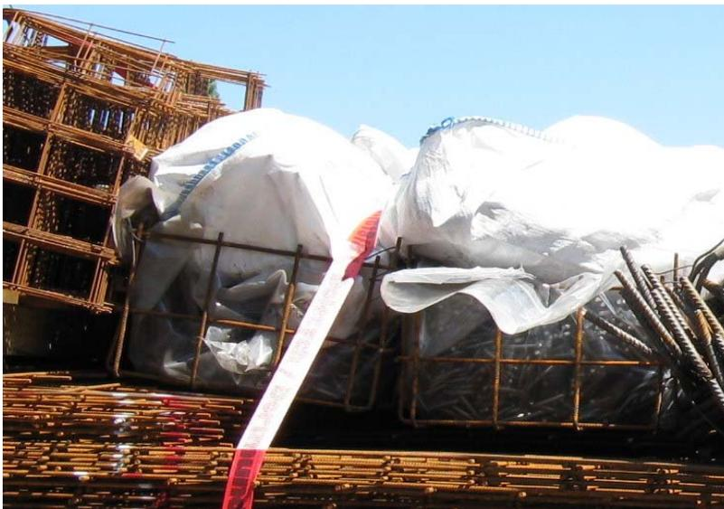
Bild 4.4: Sicheres Laden von Kleinteilen
