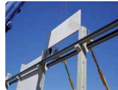
Bild 3: Typische Anwendung von Transportankern
